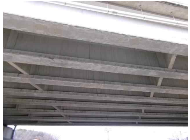
신기1교 상부구조 전경
