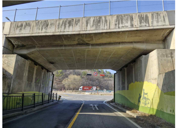
오천교차1교 상부구조 전경
