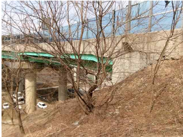
궁촌IC RAMP-B교 측면전경
