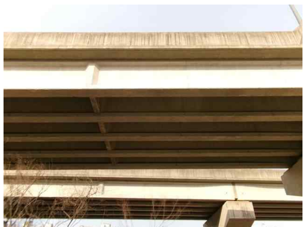
궁촌1교(하) 상부구조 전경
