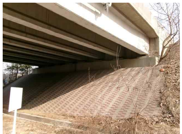
안터교 상부구조 전경
