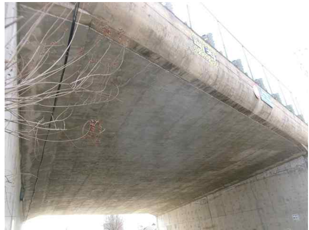
능서육교 상부구조 전경
