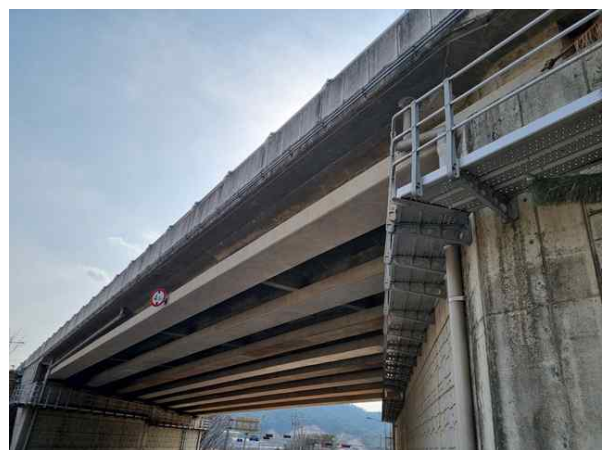
청안2교 상부구조 전경
