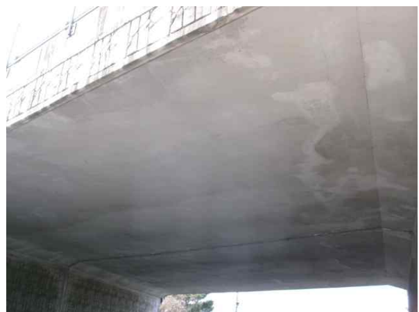
강천육교 상부구조 전경
