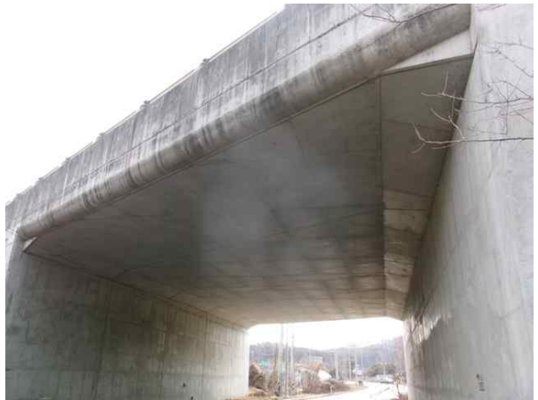
선돌교 상부구조 전경
