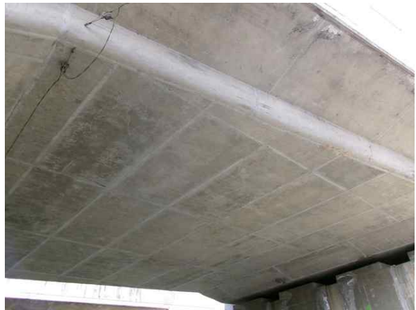
오천교차2교 상부구조 전경
