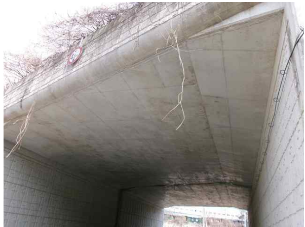
두교4교 상부구조 전경
