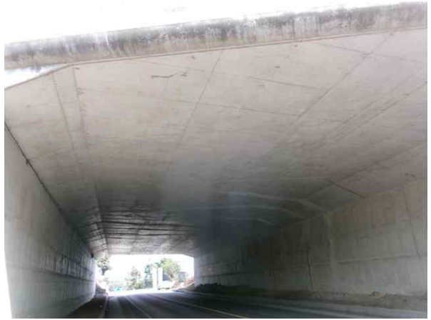
청안1교 상부구조 전경
