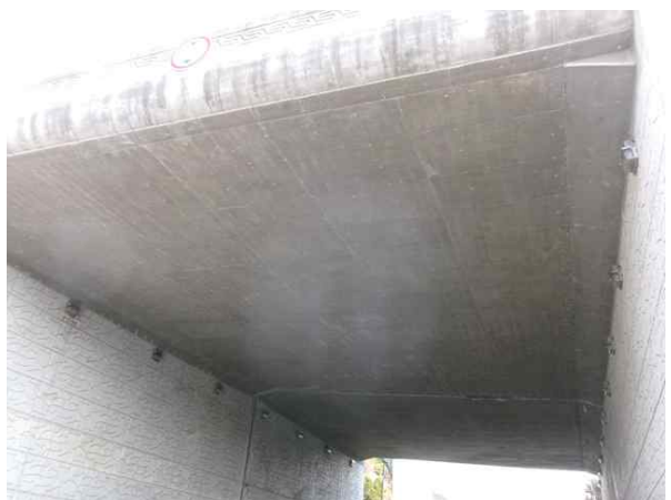
영룡1교 상부구조 전경
