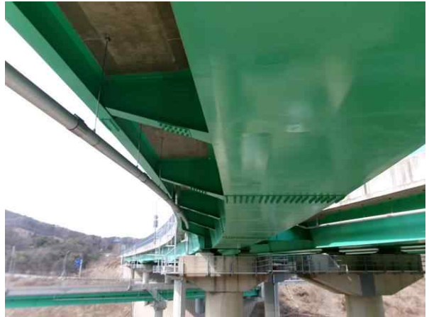
궁촌IC RAMP-B교 상부구조 전경
