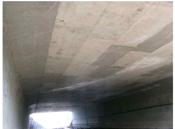
덕평1교 상부구조 전경
