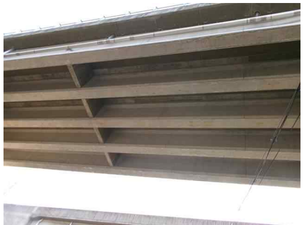
궁촌1교(상) 상부구조 전경
