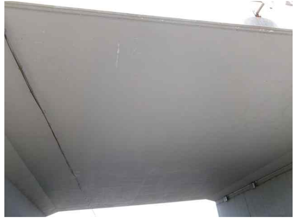
고안육교 상부구조 전경
