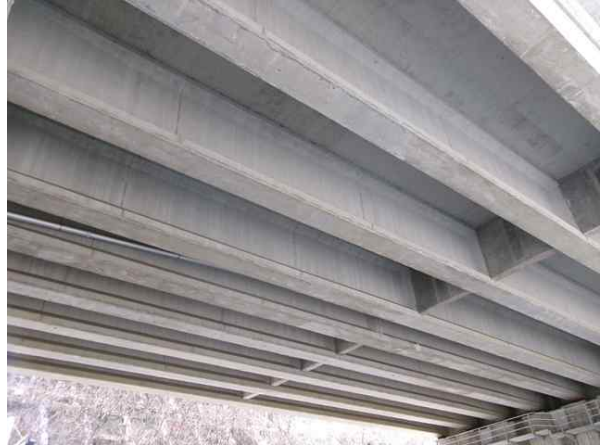
두교2교 상부구조 전경
