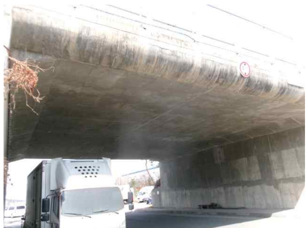
신원육교 상부구조 전경
