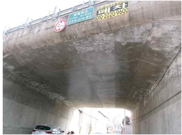
백록육교 상부구조 전경
