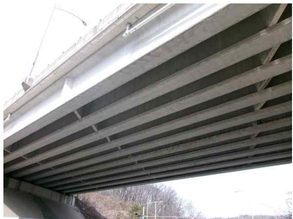
당목교 상부구조 전경
